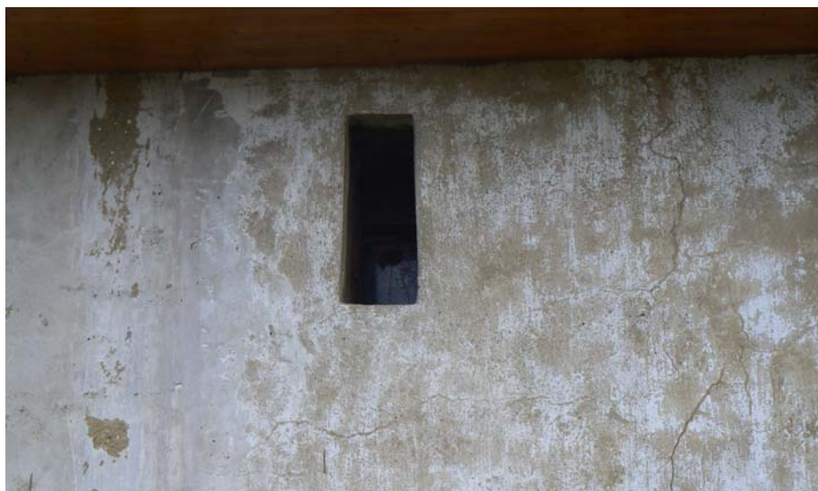
Obr. 58 : Pravděpodobná střílna v ohrazení tvrze, nacházející se nad zachovanou klenbou.
