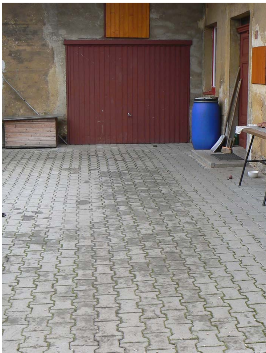
Obr. 63 : Pod touto dlažbou se nachází obložený travivod břidlicí.
