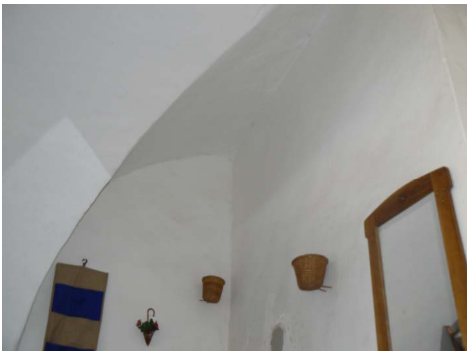
Obr. 22 : Část klenby po vstupu do bývalého čp. 33.
