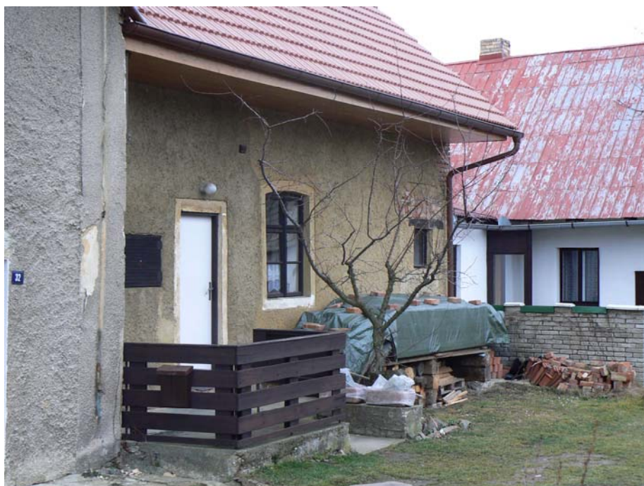
Obr. 16 : V tomto objektu se nachází zachovaná klenba, patřící s největší pravděpodobností k původní stavbě uvnitř ohrazení Příčinské tvrze.
